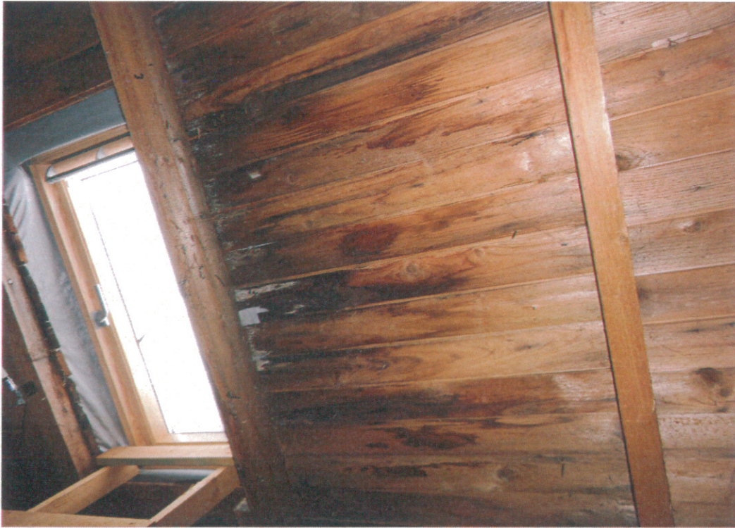
Foto 15. Lentų pakloto fragmentas ties įrengtu stogo švieslangiu. Pajuodavusi medienai puvinio pažaida.
