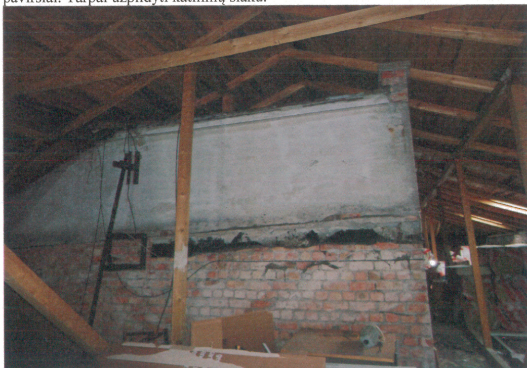
Foto 12. Laiptinės sienos ašyje 3 fragmentas pastogėje. Matomas buvęs stogo kontūras.
