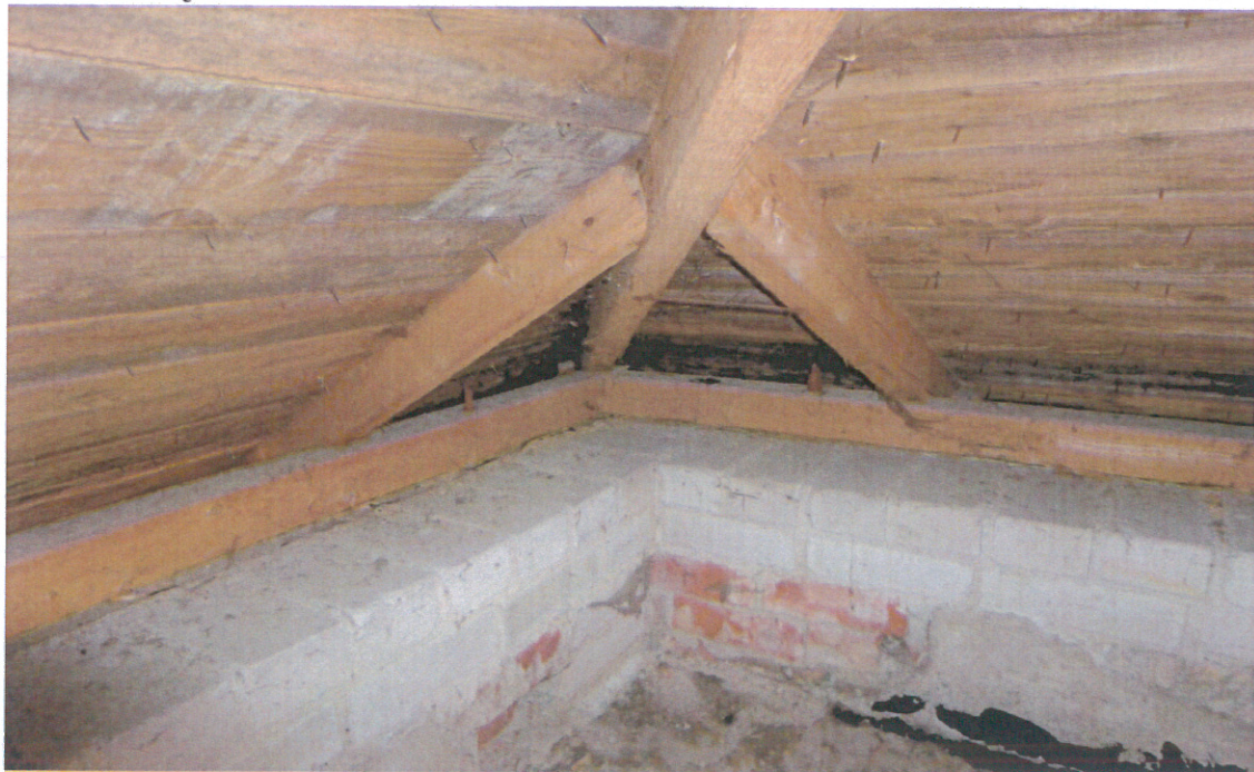
Foto 1. Bendras pastogės konstrukcijų vaizdas. Gegnės atremtos ant mūrločio bei ant viršutinio ilginio ir statramsčių.
