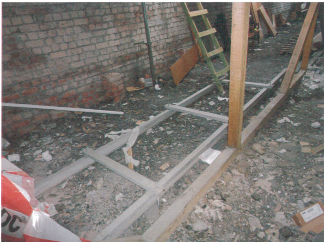
Foto 13. Pastogės perdangų sustiprinimo konstrukcija tarp ašių 3-4/A-B.
