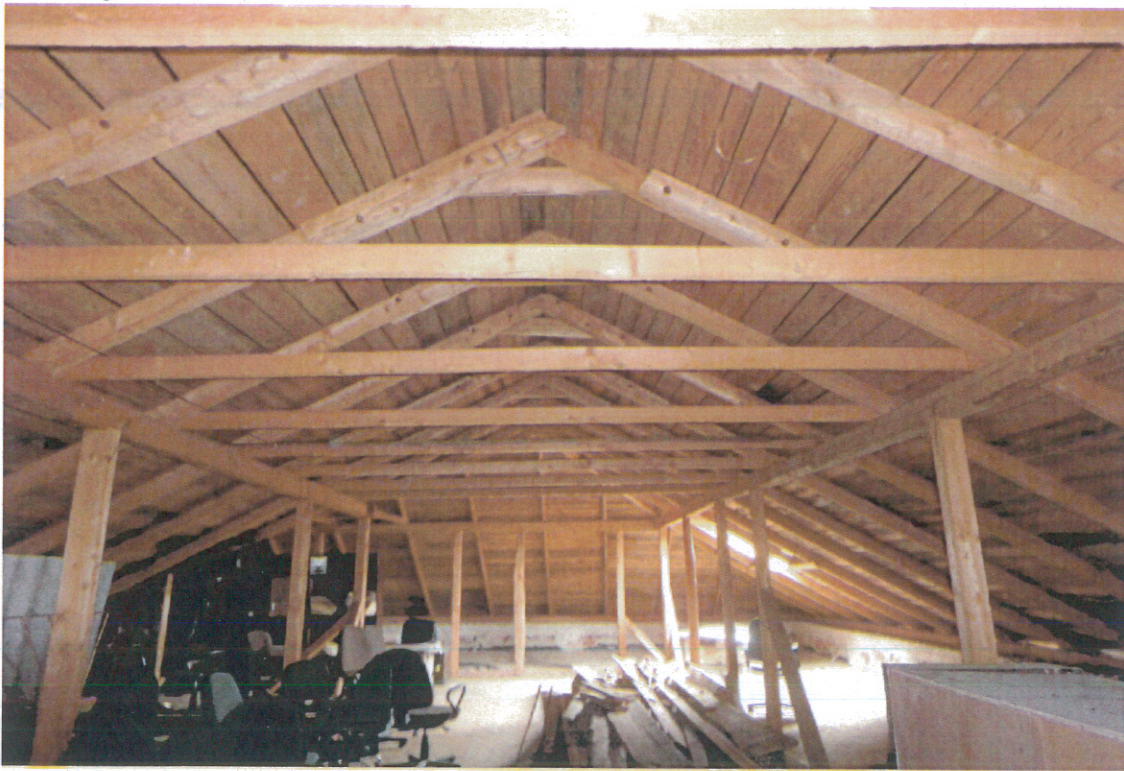
Foto 1. Bendras pastogės konstrukcijų vaizdas. Gegnės atremtos ant mūrločio bei ant viršutinio ilginio ir statramsčių.
