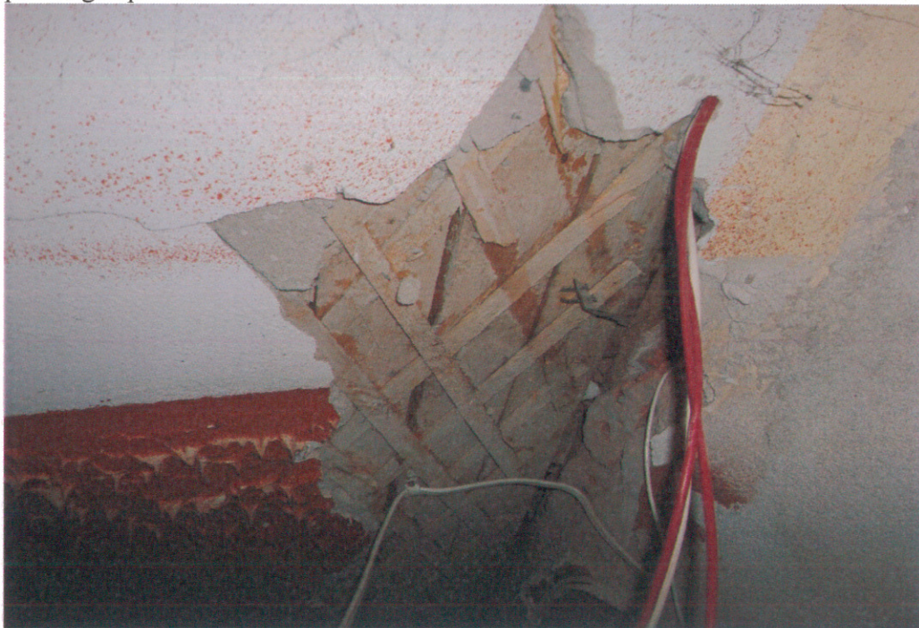
Foto 18. Medinių perdangų virš pirmo aukšto tarp ašių 4-5/A-C lubų fragmentas. Lubų tinkas suskilęs, vietomis nukritęs.
