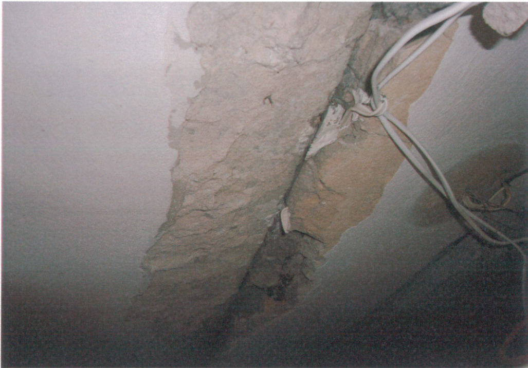
Foto 17. Perdangų siūlės fragmentas virš trečio aukšto ties deformuota perdanga. Dešinėje- įlinkusi ir vėliau sustiprinta gelžbetonio monolito plokštė; kairėje- surenkama gelžbetonio perdangos plokštė.
