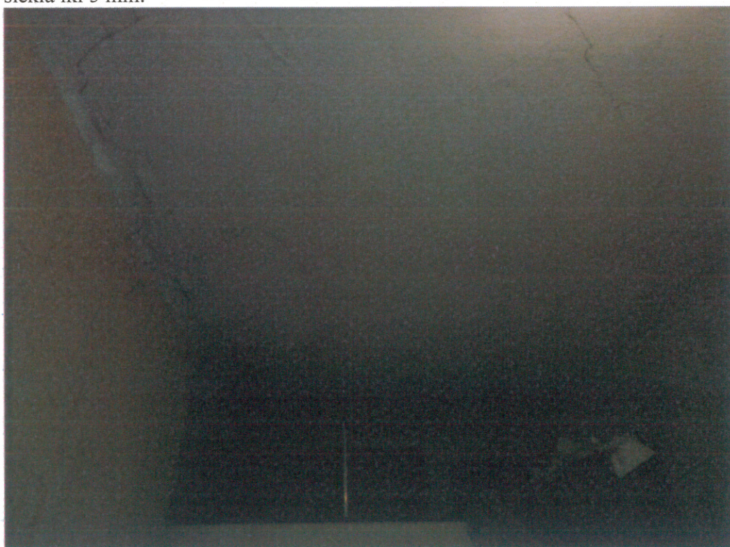
Foto 8. Plyšiai lubų tinke laiptinėje. Perdanga šioje dalyje medinė.
