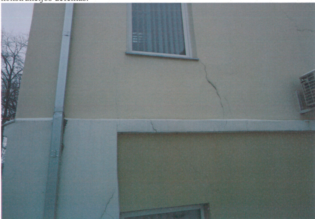
Foto 6. Sienas D tarp ašių 5-6 fragmentas. Ties langais pastebimi mūro konstrukcijas plyšiai.
