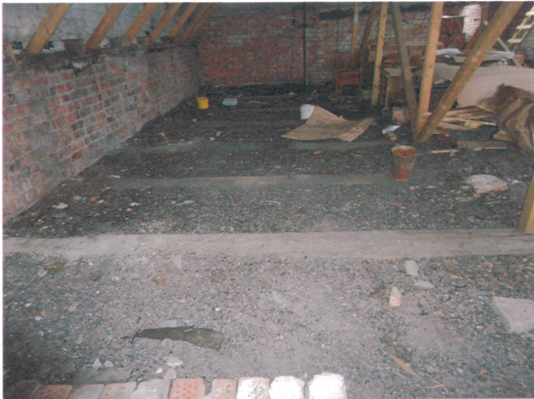
Foto 11. Pastogės medinių perdangų fragmentas tarp ašių C-D. Matomi medinių sijų paviršiai. Tarpai užpildyti katilinių šlaku.
