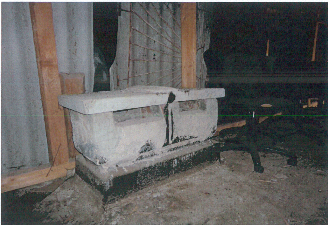
Foto 7. Esami veikiantys ventilacijos kanalų stovai pastogėje. Apatiniai ilginiai sumontuoti ant senos sutapdinto stogo ruloninės ruberoido dangos.
