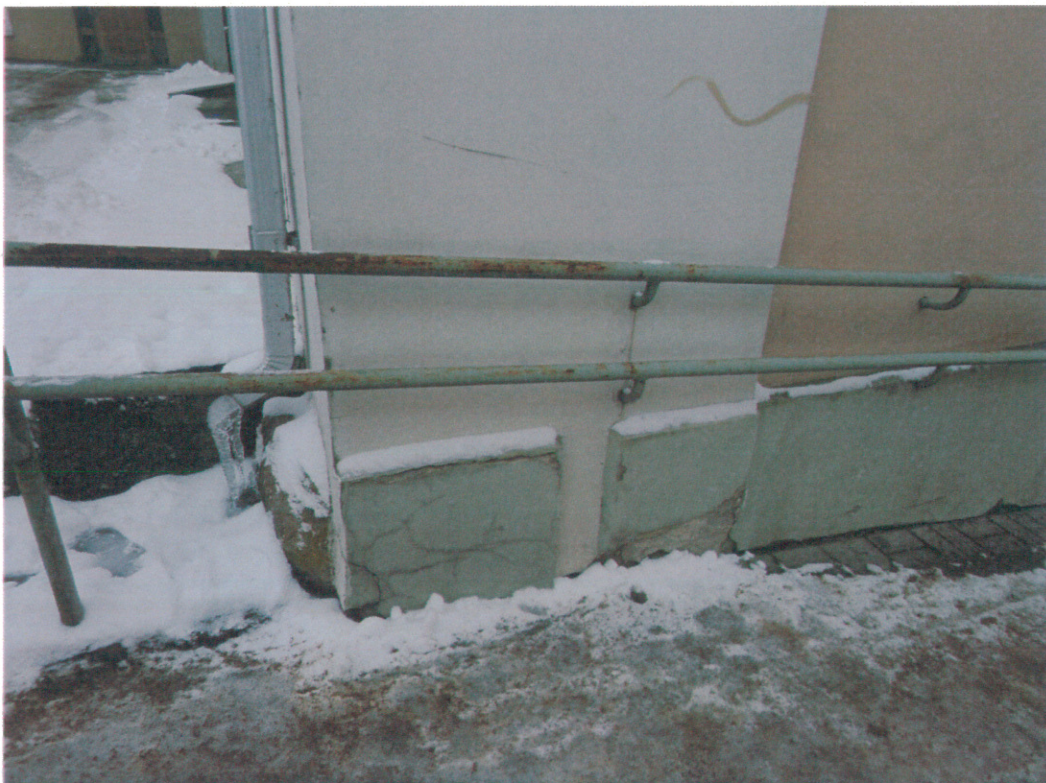
Foto 5. Cokolio fragmentas. Matomi atrūpējē tīnko tarpai ties grindiniu. Tai būdingas konstrukcijas defekts.
